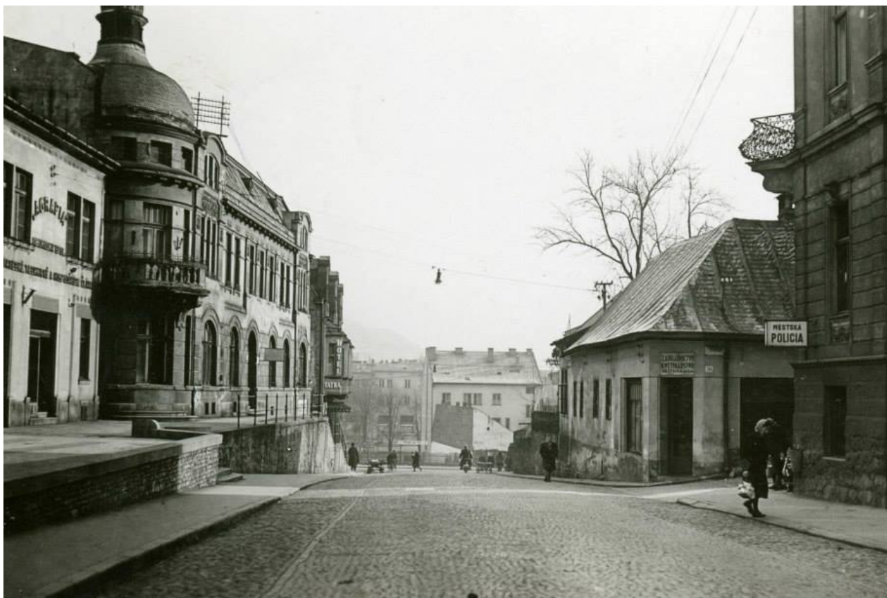
Detaily systému dláždenia komunikácií v meste v prvej polovici 20. storočia. Hore Hurbanova ulica: chodníky pre peších majú pevný liaty povrch, jazdná časť cesty je dláždená čadičom do vejárov, odstavné pruhy sú vizuálne oddelené a dláždené odlišným spôsobom. Na fotografii dolu je križovatka dnešnej Národnej ulice s Hviezdoslavovou pred železničnou stanicou s čadičovou dlažbou kladenou do vejárov.
